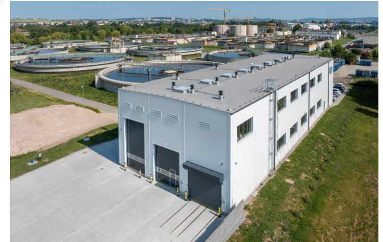
Neutralizační a deemulgační stanice, Brno Více ZDE
